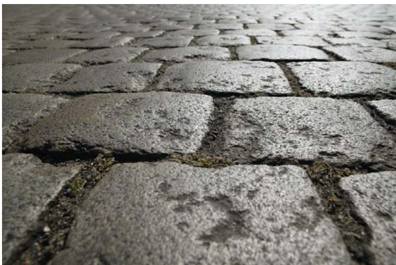
Foto 10 Brede voegen tussen klinkers zorgen voor een verhoogde waterdoorlatendheid. Foto: Phovoir
